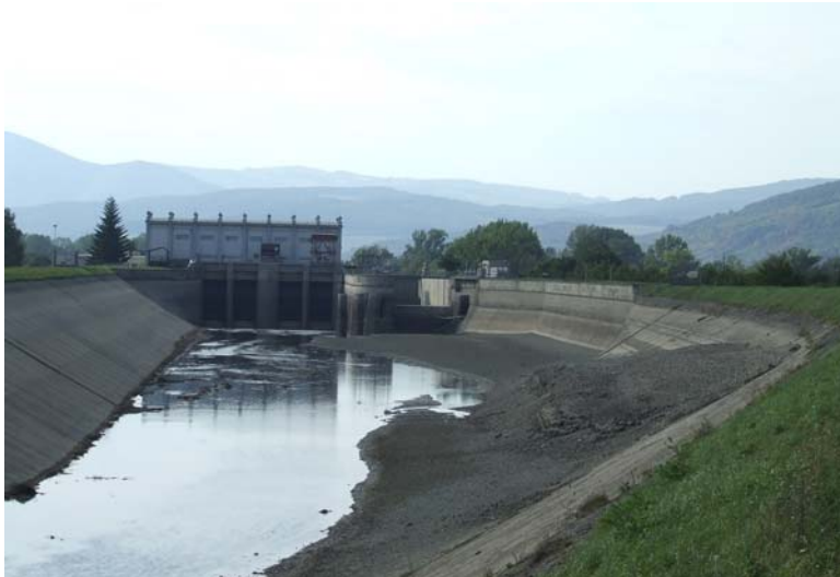
hydrocentrála v Trenčíne po vypustení derivačného kanála
